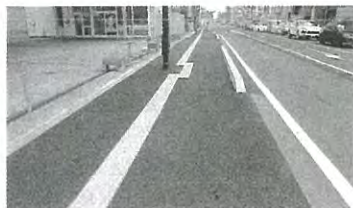
歩道整備 (安全対策) 北六番丁交差点
