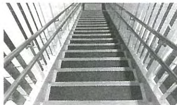
歩道橋階段整備 通町歩道橋
