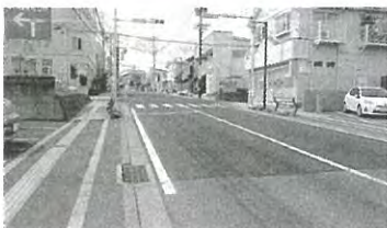
道路修繕 (安全対策) 中山商店街バス通り
