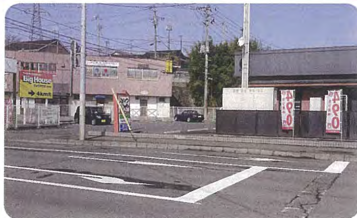
将監団地入り口交差点(泉消防署4号線バイパス)の停止線を変更して狭あい感が改善されました
