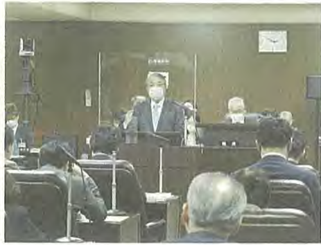
2・13福島沖地震で本会議場の天井破損により特別委員会室での本会議
