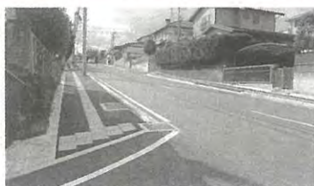
道路修繕(安全対策) 中山6丁目地内
