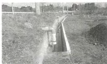
側溝整備 熊ヶ根字町二番地内
