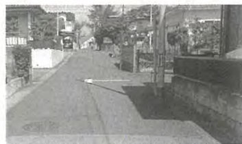
道路修繕(安全対策) 桜ヶ丘6丁目地内
