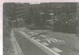
残りの拡幅工事が決まったうなり坂
