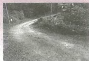
近日中に舗装工事に入る砂利道
