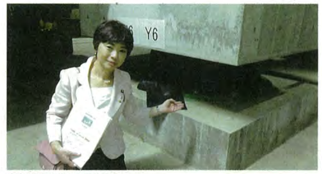
病院の躯体を守る免震装置
