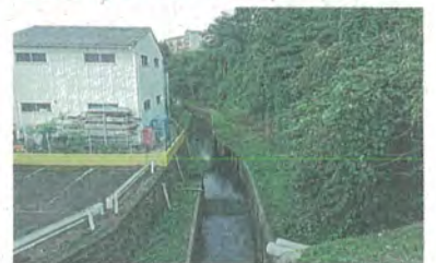
鷺ヶ森1丁目地区の源太兵衛川流域の護岸を整備
