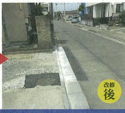
▲南小泉4丁目凹凸の側溝と雨水が抜けるよう整備
