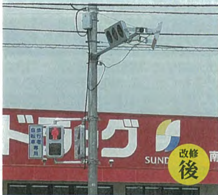
▲サンドラック前交差点信号機：視野性の悪い信号をLEDに改修
