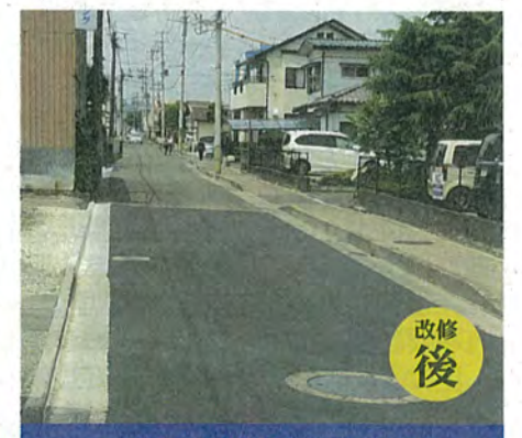
▲凹凸の道路と側溝整備
