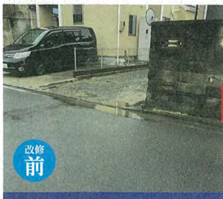
▲南小泉4丁目凹凸の側溝と雨水が抜けるよう整備
