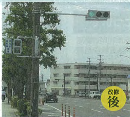
▲サンドラック前交差点信号機：視野性の悪い信号をLEDに改修
