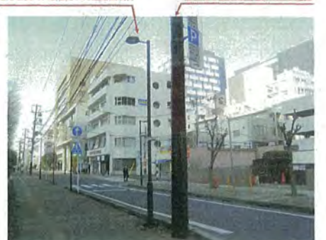
既存の照明灯が撤去され、電力契約のみが存在している電柱
