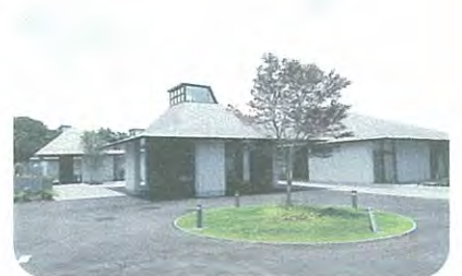
平成30年4月に整備された横浜市の「日野こもれび納骨堂」
