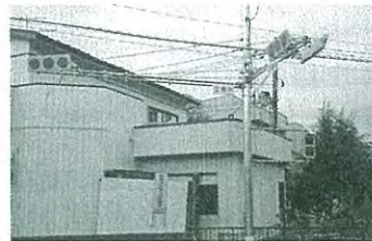
信号機設置 (安全対策) 川平・桜ヶ丘T字路
