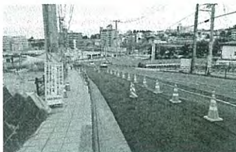
ロードヒーター改修 (安全対策) 中山幹線一号线
