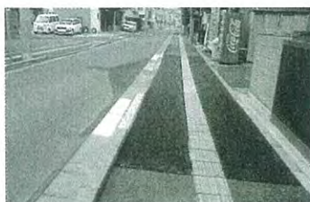
歩道修繕 (通学路安全対策) 上杉山通小学校付近
