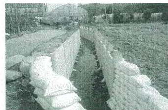
用水路整備 (雨水対策) 上愛子北内地内
