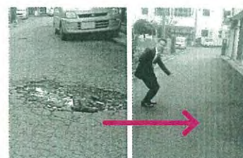
道路修繕 (通学路安全対策) 作並小学校入口
