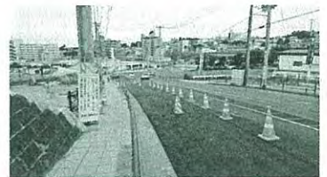
改修が進められている ロードヒーター工事
